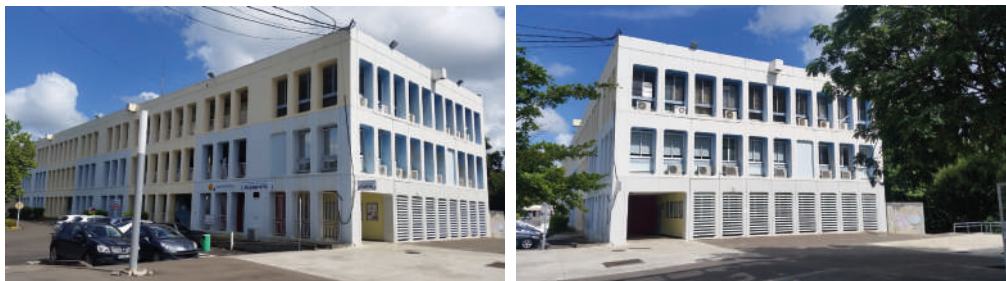
État actuel du bâtiment enseignement de l'UFR SEN avant travaux
